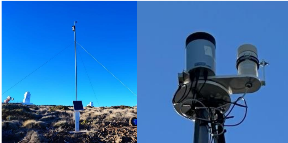
Figura A.10. Panel izquierdo: estación meteorológica de la red ASTRI, situada cerca del telescopio ASTRI-2. Panel derecho: cámara de todo el cielo (All Sky Camera) junto con el monitor de calidad del cielo (Sky Quality Monitor).
