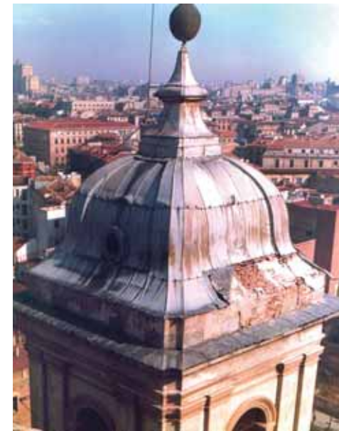
93. Planchas de plomo desprendidas del chapitel de la torre.
