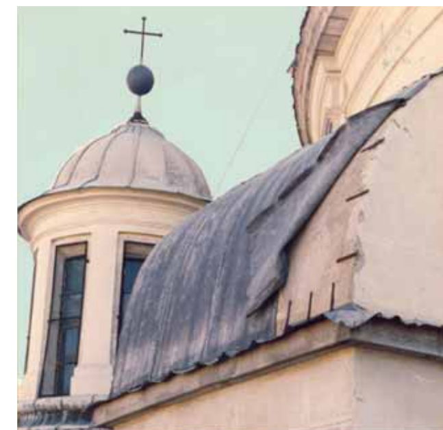
95. Plomo levantado en contrafuerte.
