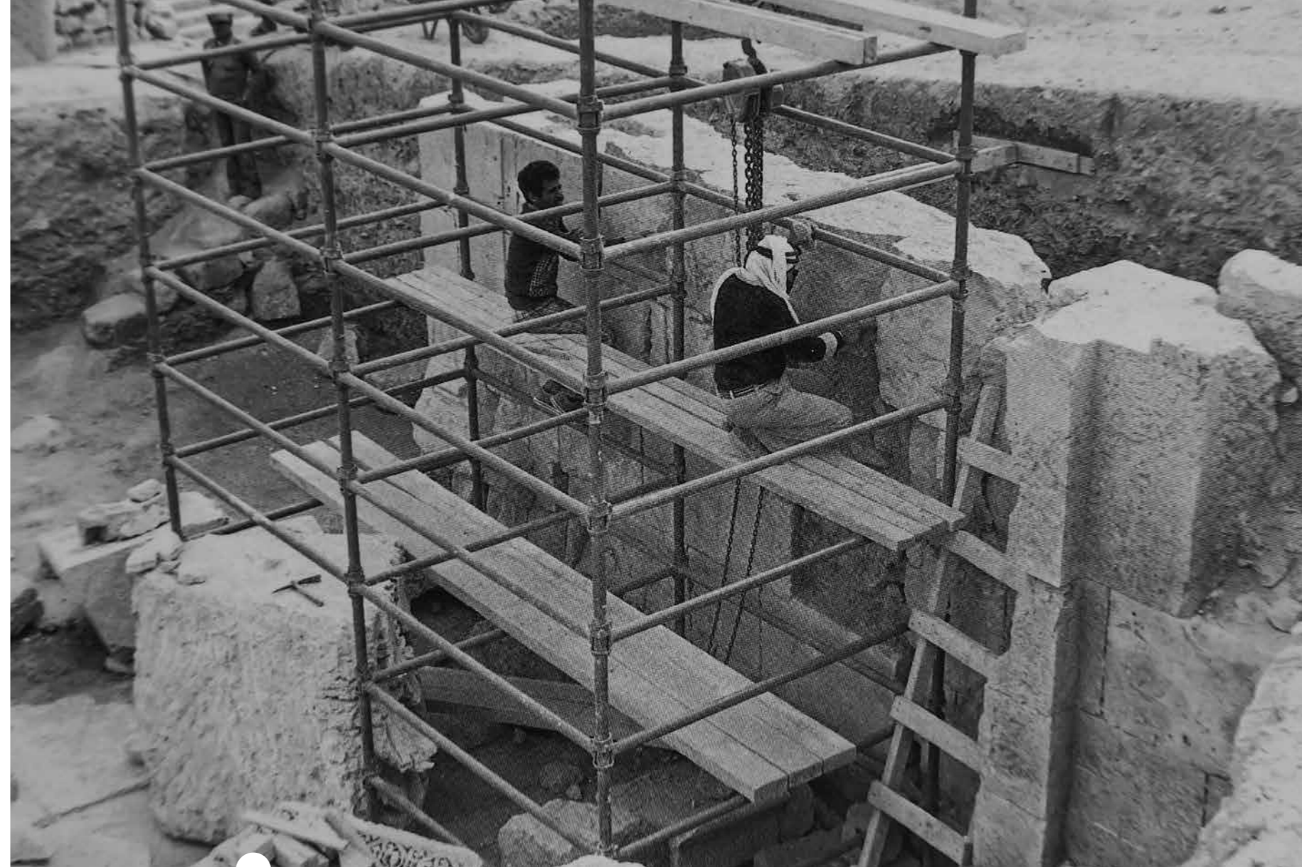
Trabajos de restauración de la pared sur del vestíbulo exterior de Gerasa.
